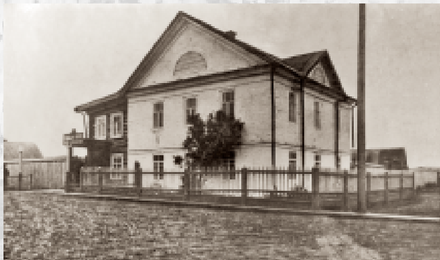
Здание Крестьянского поземельного банка в селе Сива Оханского уезда Пермской губернии. Начало XX века
